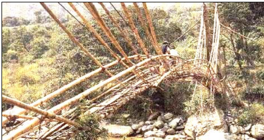
Foto 11: El viejo puente de Avirama, Paez, Tierradentro, Colombia, tenía 40 metros. Similares puentes todavía se encuentran, pero requieren renovación cada 2 a tres años, por ende se siembra una mata cerca al ponteadero. La guadua trabaja de forma atirantada y con tallos de arco natural desde cada orilla.
