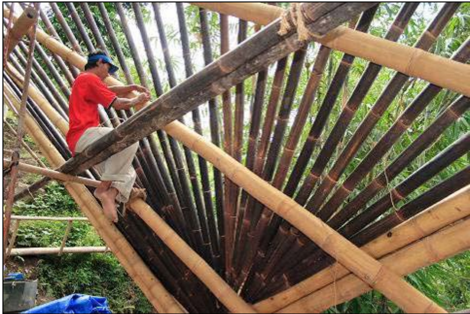
Foto 14: Las dos direcciones opuestas del bambú amarillo y del negro crean rombos (entonces todavía no están determinadas), pero la capa final de listones envueltos en paja, amarrados en la estructura, lo conjura como una sola superficie con forma activa.
